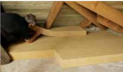
Mit den stabilen STEICO<sup>top</sup> Dämmplatten lassen sich schnell große Flächen dämmen. Der Anschluss an Details wie Fußpfetten gelingt passgenau. Da die Platten glattkantig sind, müssen bei STEICO<sup>top</sup> Randstücken keine Plattenprofile beigearbeitet werden; schwieriges Einpassen unter beengten Platzverhältnissen entfällt. Wird zweilagig gearbeitet, empfiehlt sich die Verlegung mit Stoßfugenversatz.
